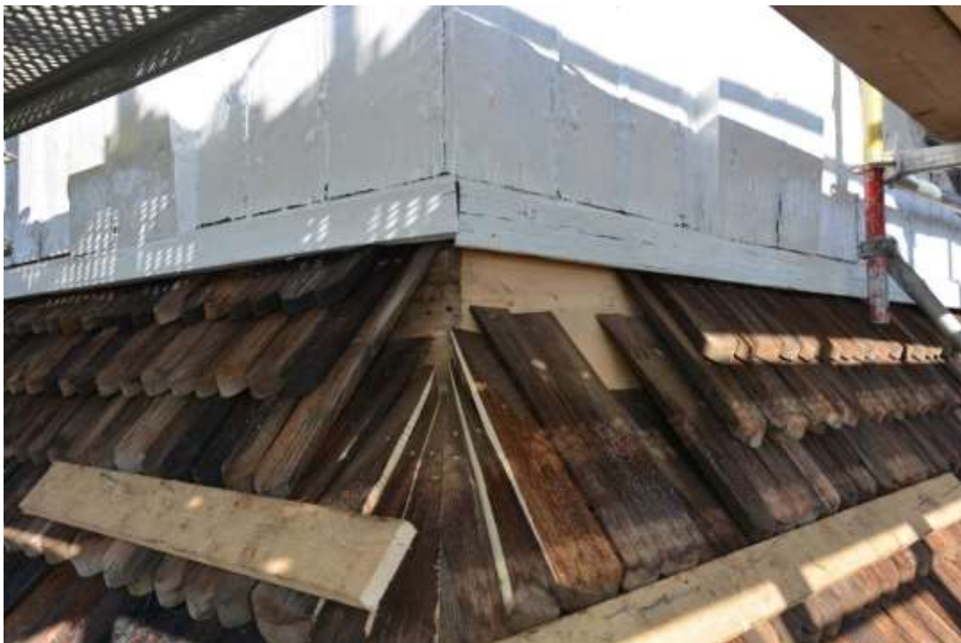
Montering av spån. BildID:Vlm_kmvSB-4214.
