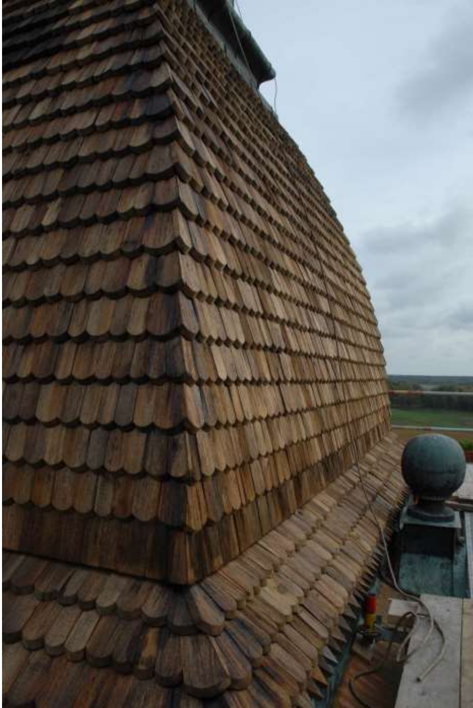
Taket efter slutfört arbete med spånläggning. Foto: Lars-Åke Augustsson.
