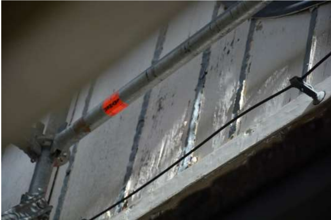
De frilagda zinkbanden efter skrapning. BildID:Vlm_kmvSB-4211
