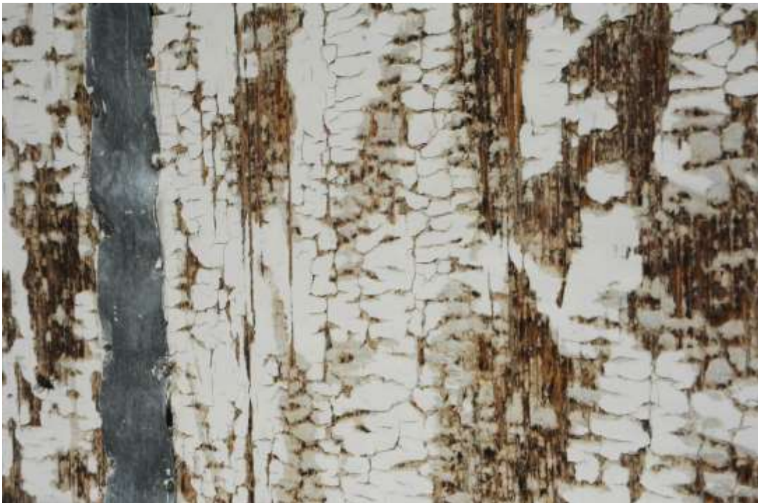
Under det yttersta färglagret fanns en mörkare grå kulör. Foto: Lars-Åke Augustsson.
