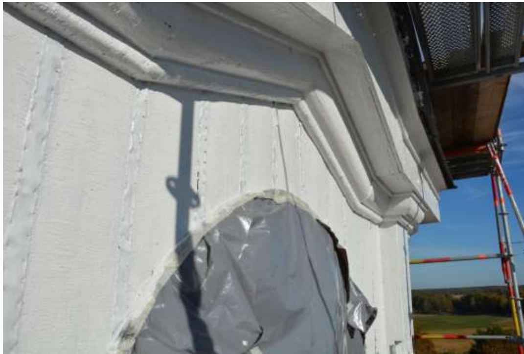
Metallbanden och panelen ströks med linoljafärg i kulören NCS S 1000-N. BildID:Vlm_kmvSB-4219.
