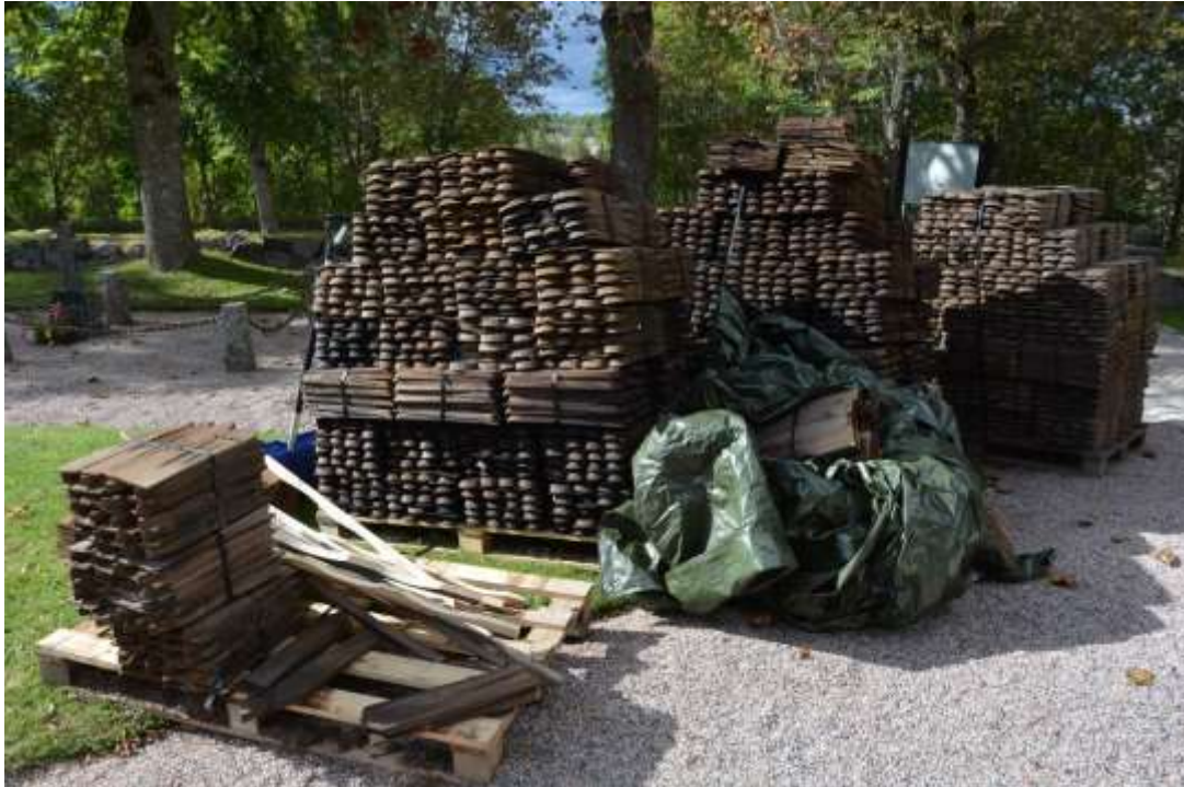
Spånen levererades färdigstrukna med tjära. Ytterligare ett lager tjära kommer strykas ett år efter färdigställt arbete. BildID:Vlm_kmvSB-4208.
