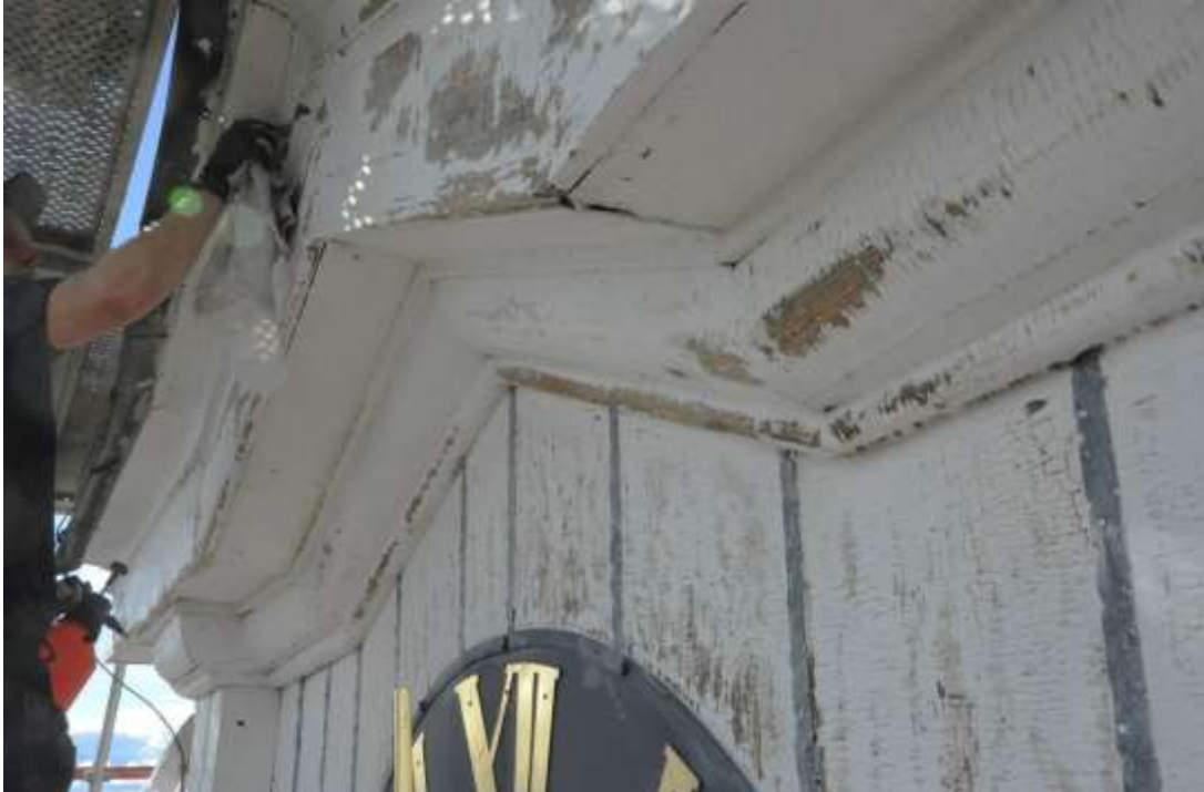
Panelen och metallbanden har skrapats rena från löst sittande färg. Foto: Lars-Åke Augustsson.
