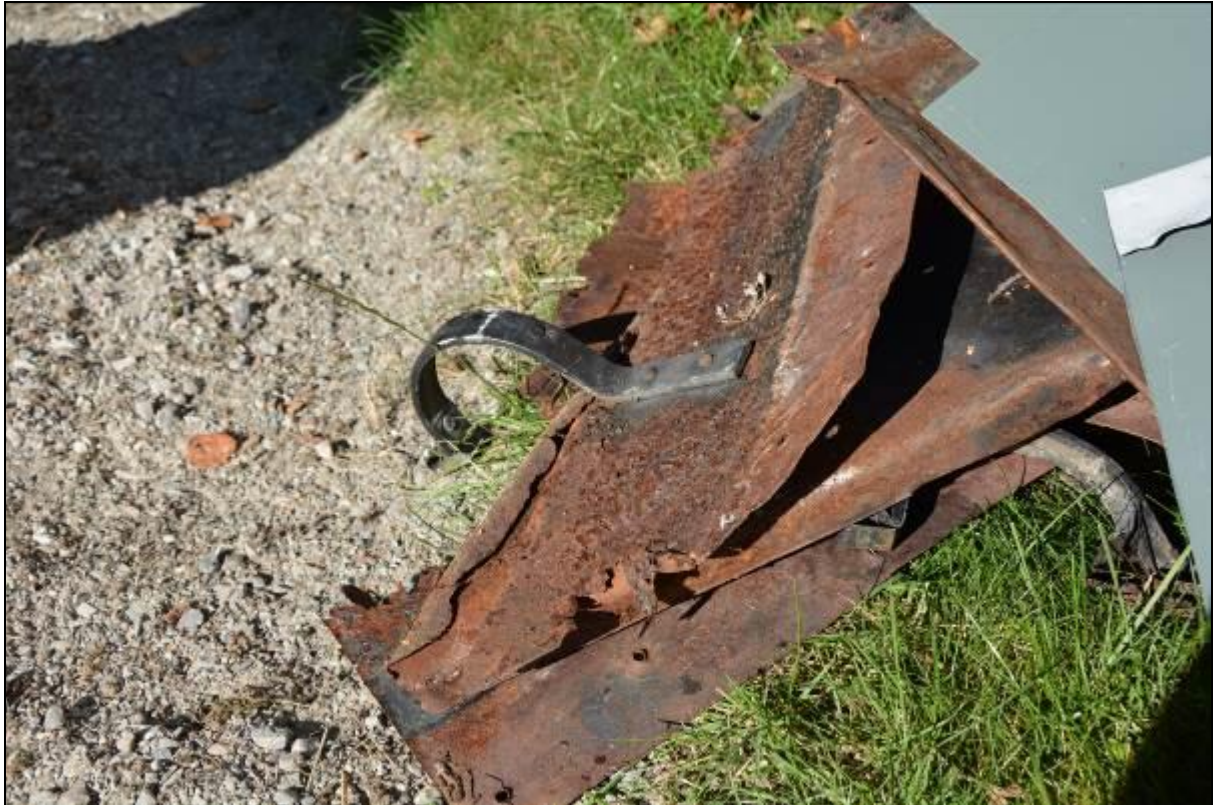
Äldre plåt med fastsatta krokar för hängrännor. Vlm_kmvSB-2492
