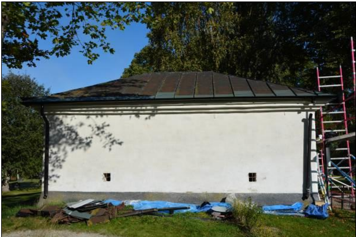
Södra takfallet efter plåtbyte. Vlm_kmvSB-2483
