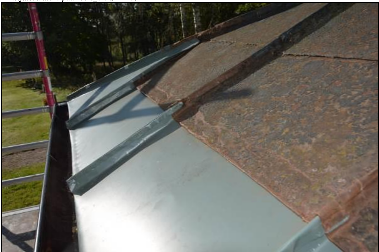
Ny plåt på nedersta varvet. Vlm_kmvSB-2488
