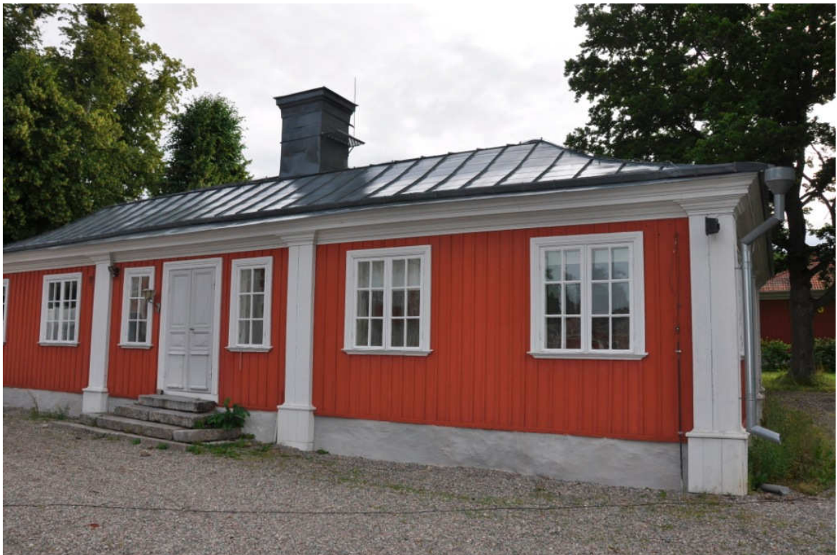
Bild 6 , Byggnaden efter grundmålning. Bild Vlm_kmvFE-1424.
