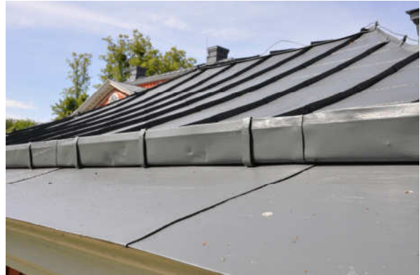
Bild 8 , södra takfallet efter slutstrykning. Bild Vlm_kmvFE-1488
